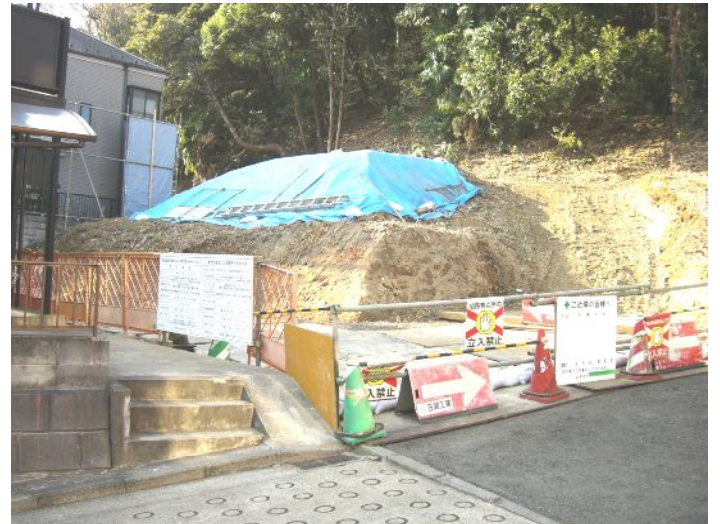
マンション工事現場
