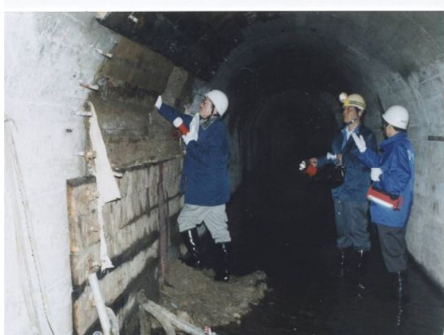
工事を点検する横浜市職員(02年1月)
