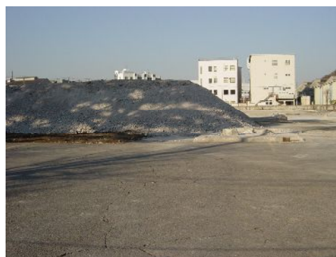
本庁舎が破壊された跡(04年12月25日現在)
