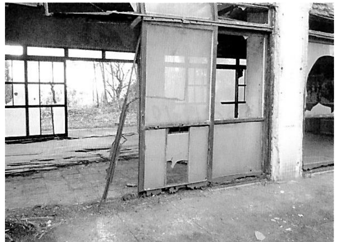
寄宿舍南寮1階の床面（修復前）
