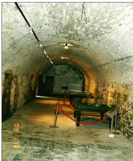
淡水砲台の地下壕 (筆者撮影)
