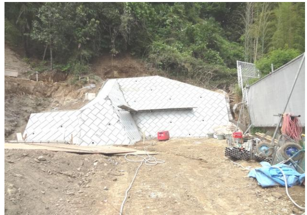
北側沈殿槽前に築かれた擁壁
