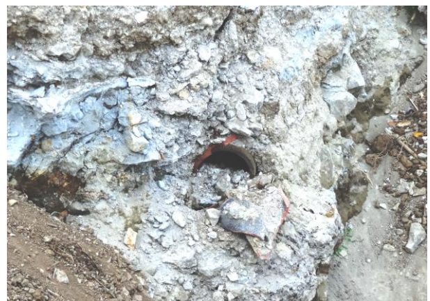
6a 入口坑道下の土管 (まだ6a 入口は埋もれている)
