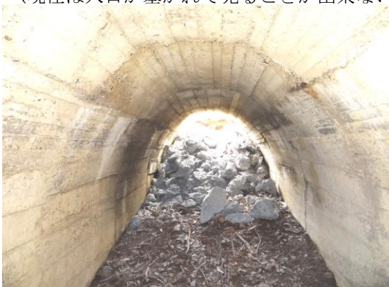
7a 坑道内部より入口
