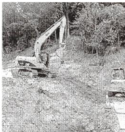
開発が進む日吉台地下壕の出入り口周辺＝横浜市港北区
